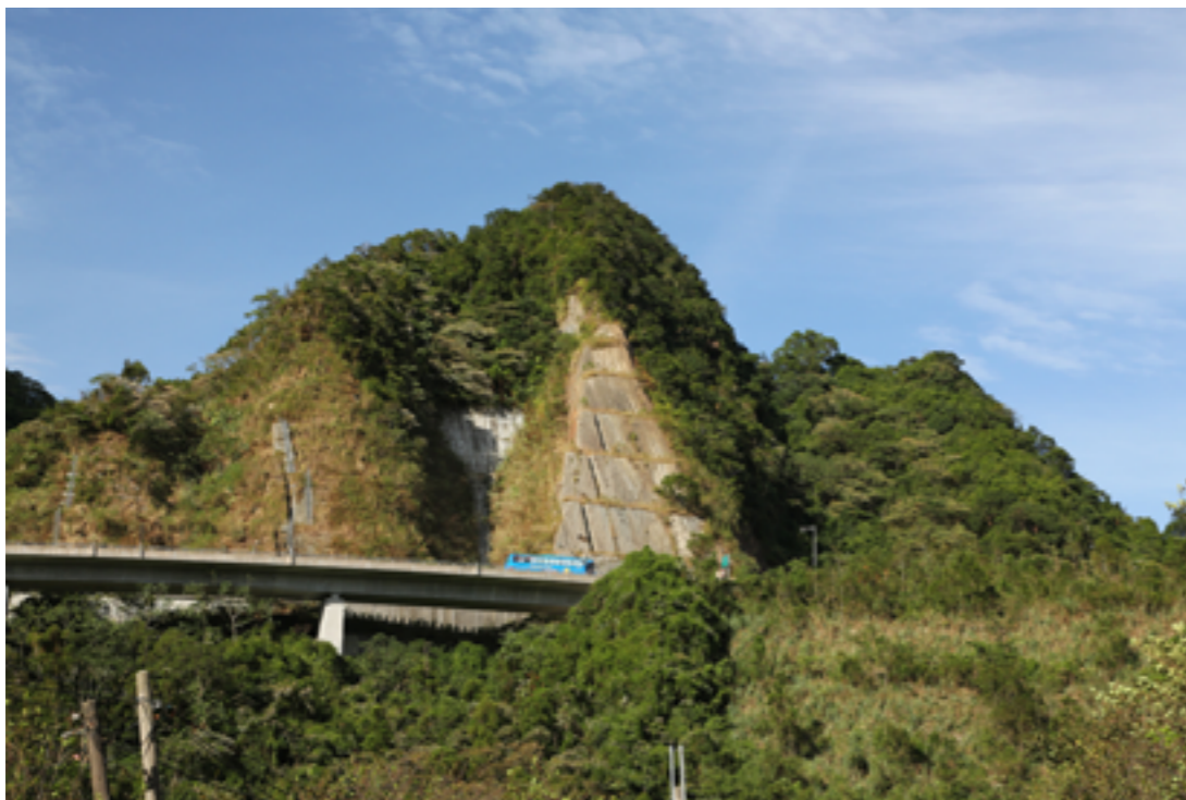
山區陡峭的山坡或高陡的道路邊坡是崩落經常發生之地區。 (資料來源：施堅仁 / 攝)
