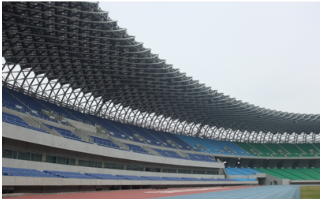
高雄國家體育場館屋頂是使用多達 8,844 片玻璃壓縮的太陽能光電板組成，為全球第一座具有 1 MW (百萬瓦) 太陽能發電容量的運動場。經臺灣 EEWH 評定為黃金級的綠建築。
