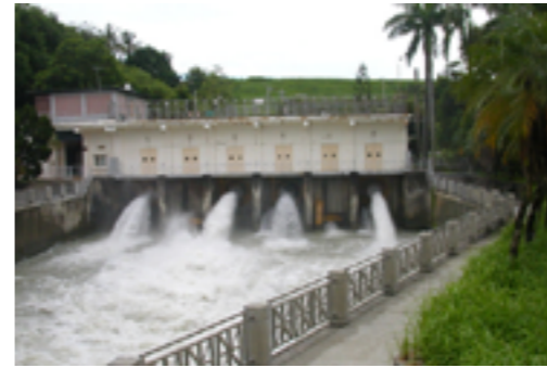
圖為烏山頭水庫之舊送水工作站，於1930年建造完成，1997年因新送水設施完成營運後，其功能目前僅為輔助及調節用水。 (資料來源：烏山頭水庫風景區)
